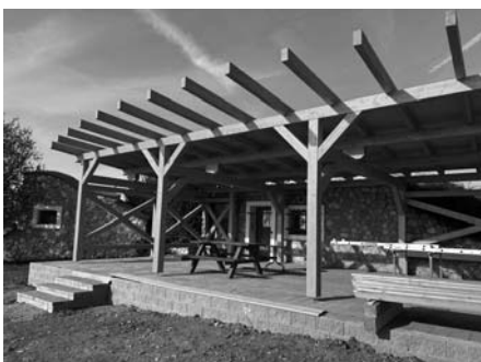
Nová pergola před kioskem pod rozhlednou Slunečná těsně před dokončením.
