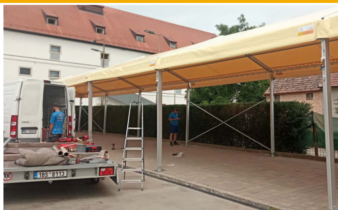
Instalace nového přístřešku na tanečním sóle za sokolovnou
