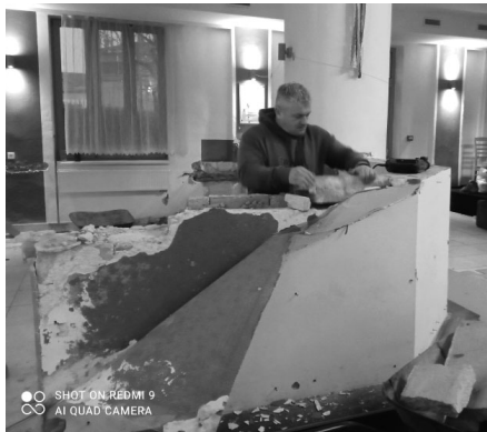
Demolice barového pultu v sokolovně.
