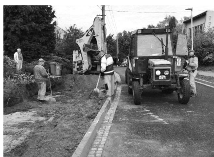
Oprava vozovky v horní části ulice V Sadech.
