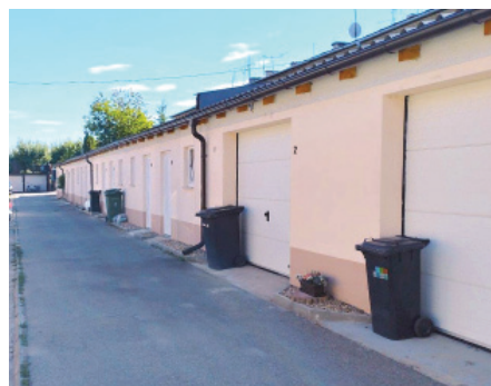
Pronajímané skladové prostory na ulici Tovární.
