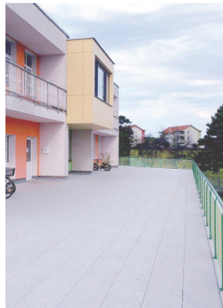
Zrekonstruovaná terasa na budově mateřské školy.
