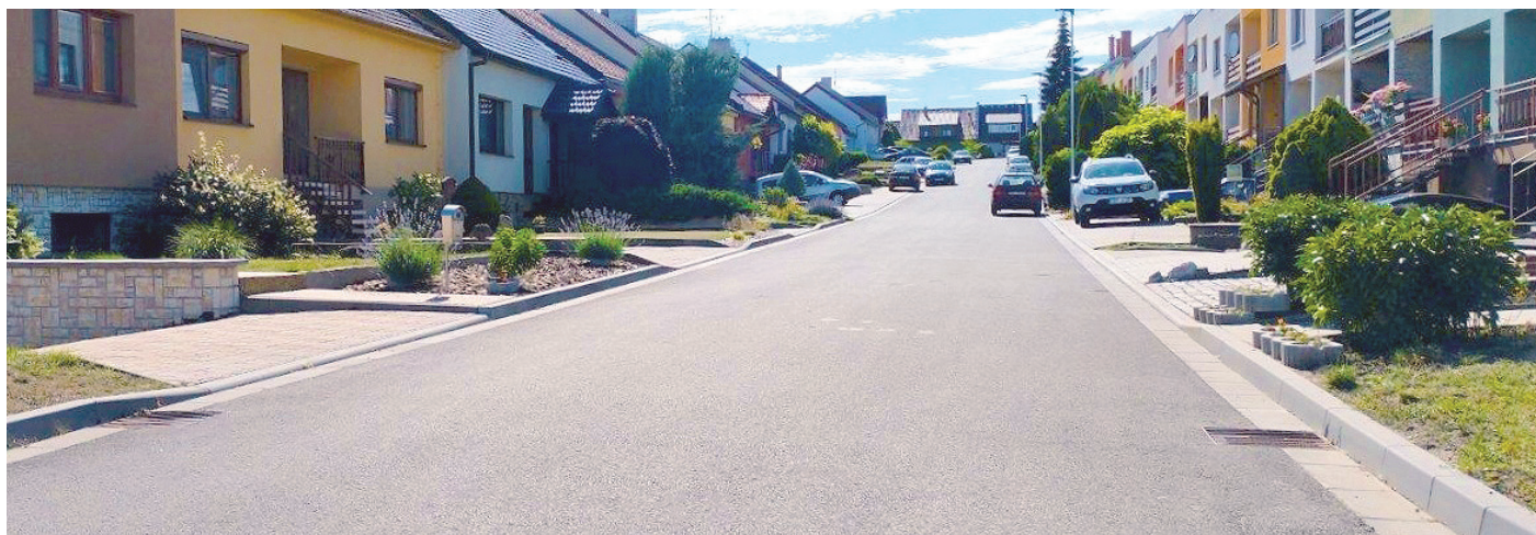
Opravená vozovka na ulici Kpt. Jaroše.
