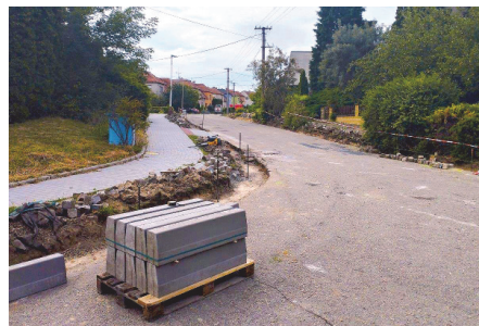
Zahájení rekonstrukce vozovky v horní části ulice V Sadech.
