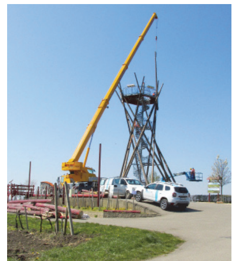
Výměna dřevěných kůlů na rozhledně Slunečná.
