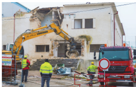
Zahájení demolice budovy kina.
