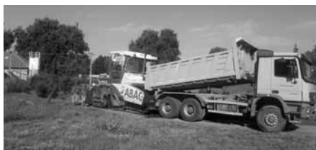
Vozovce podél potoka Trkmanka, v sousedství ČOV, se dostalo nového povrchu.
