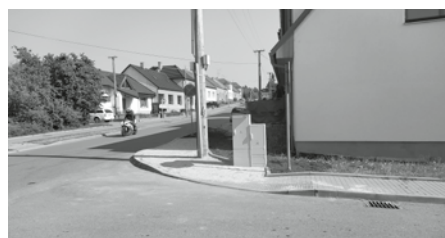
Opravený chodník s novým rozvaděčem veřejného osvětlení na rohu Bálkovy uličky.
