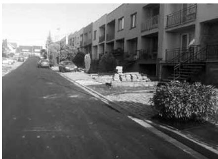
Na ulici Kpt. Jaroše byla komplet zrekonstruována vozovka.
