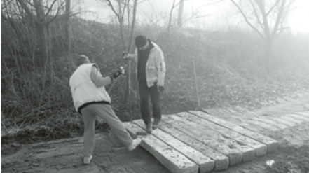
Oprava polní cesty – pokládání betonových panelů.
