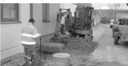
Práce na výstavbě nových parkovacích míst na ulici Tovární.
