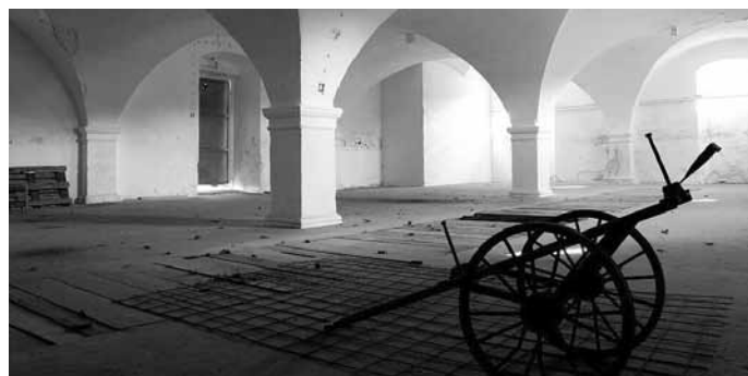
Interiér přízemních prostor velkopavlovické sýpky před zahájením rekonstrukce na hotel.
