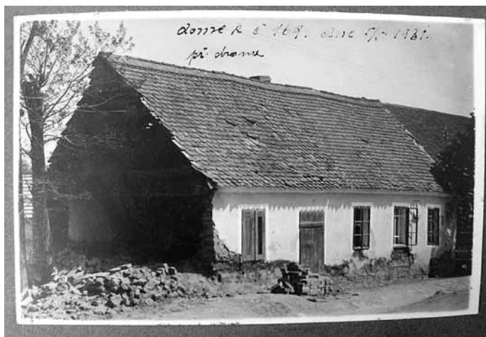
Domek č. p. 169 – četnická strážnice – fotografie přední strany budovy byla pořízena těsně před demolicí 5. května 1931.
