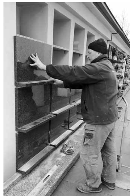
Osazení nových míst v kolumbáriu kamennými deskami.
