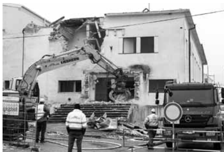
Zahájení demolice budovy kina.
