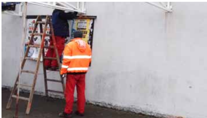
Na autobusovém nádraží byly odstraněny nevyhovující přístřešky nad místy pro stání. Nahradily je nové.
