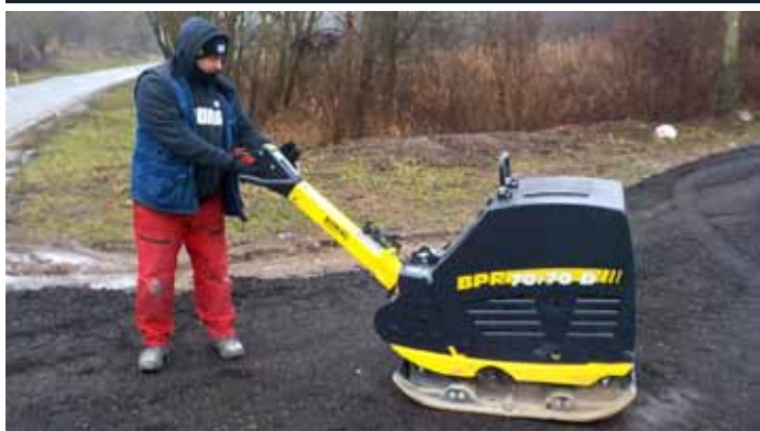
Služby města pracují na opravě polní cesty. Asfaltový recyklát je třeba řádně udusat.
