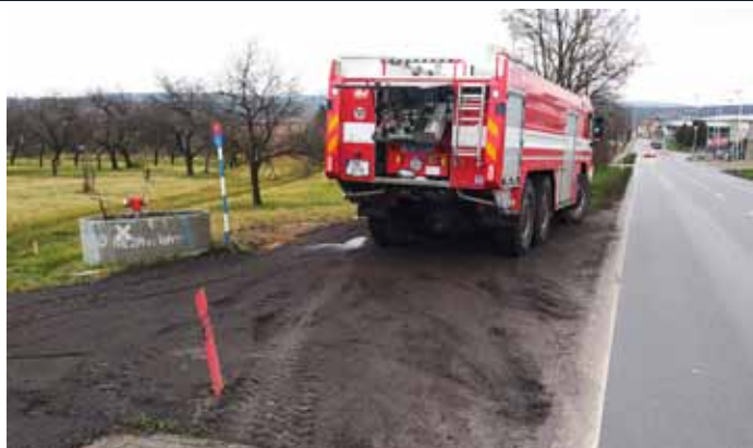
Na ulici Brněnská byla vytvořena zpevněná parkovací plocha u hydrantu, který slouží jako velkokapacitní zdroj pro naplnění cisterny hasičského auta.
