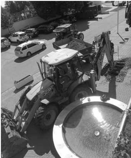
Na náměstí bude nový vodovod, opravy začaly v květnu.
