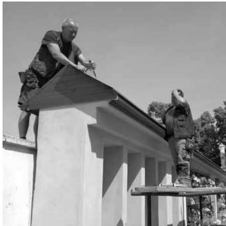
Klempíři pracují na pokládce stříšky na kolumbáriu.
