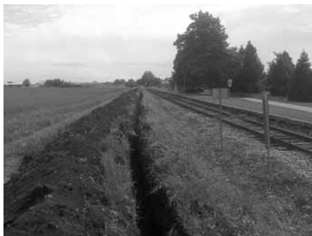
Květnové přípravné práce na opravu železničního přejezdu.
