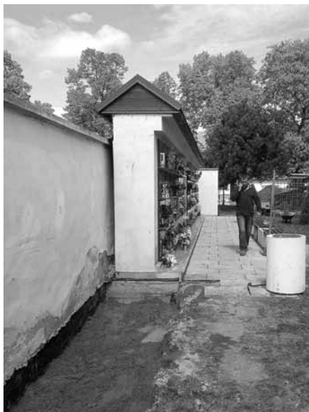
Zahájení přístavby kolumbária u místního hřbitova.
