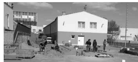
Oprava vozovky a parkoviště u vstupu do Vinných sklepů Františka Lotrinského.
