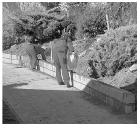
Stavba zpevňovací zídky podél chodníku za prodejnu COOP.
