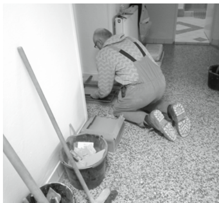
Oprava toalet v budově velkopavlovického gymnázia v období jarních prázdnin.
