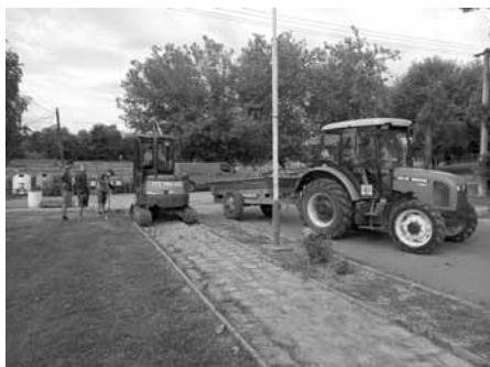
Zahájení opravy vodovodu a chodníku na ulici Herbenova.
