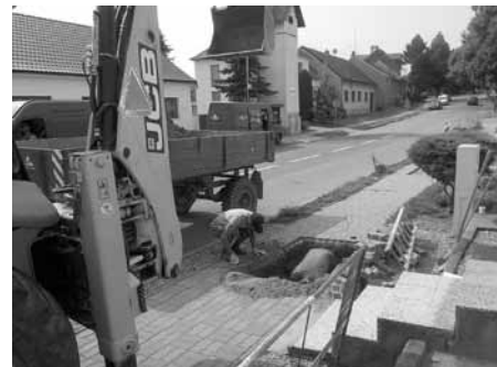
Srpnová oprava vodovodu na ulici Hlavní.
