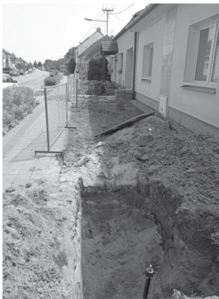
Výměna vodovodního řadu na ulici Pod Břehy.
