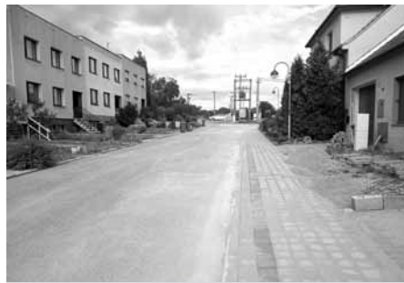
Na ulici Zahradní byla dokončena oprava chodníku.
