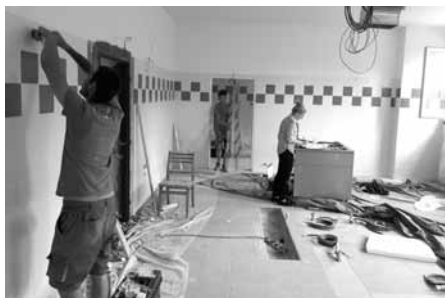
Školní kuchyně MŠ se po stavebních úpravách dočkala nového gastro zařízení.
