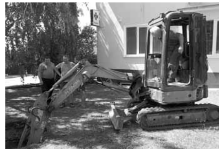
Zahájení opravy vodovodu na Náměstí 9. května, před budovou lékárny.
