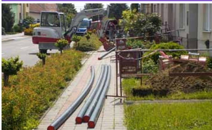
Ulice Pod Břehy – oprava vodovodního řadu
