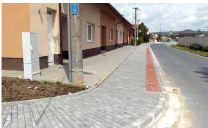
Ulice Za Dvorem po rekonstrukci vodovodu a chodníku
