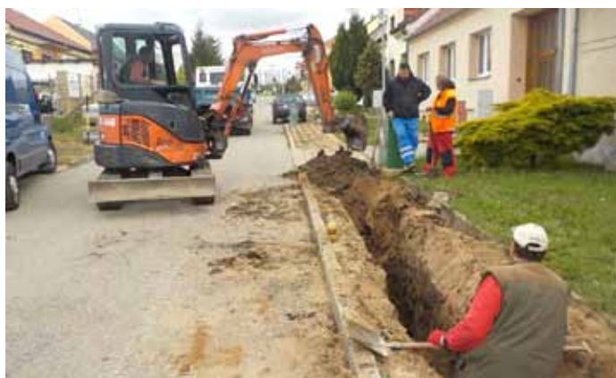
Ulice Zahradní – oprava vodovodního řadu
