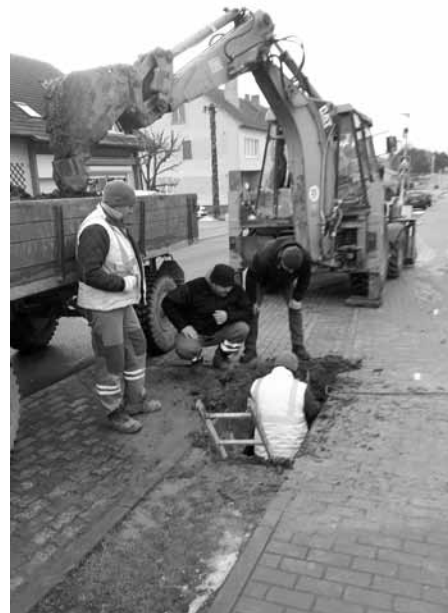
Oprava vodovodu před pekárnou na ulici Dlouhá.
