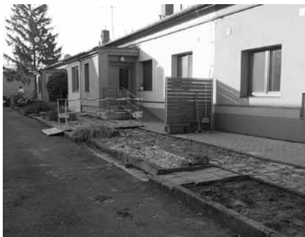
Zahájení opravy kanalizace na ulici Tovární.
