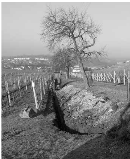
Budování kabelového vedení přípojky elektrické energie od ŠSV po kapli sv. Urbana.
