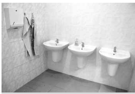
Oprava sociálního zařízení v budově gymnázia.
