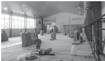
Oprava parketové podlahy ve sportovní hale základní školy.
