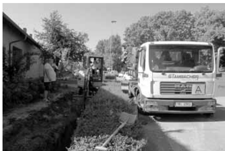
Připojení domů na nový vodovodní řad v ulici Zelnice.
