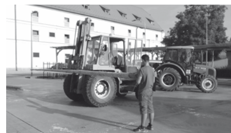
Příprava holovin pro stavbu přístřešku na sóle za sokolovnou.
