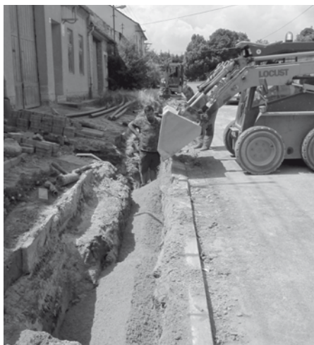
Pokládka nového vodovodního potrubí na ulici Zelnice.
