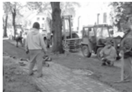
Rozebírání zámkové dlažby – chodník na ul. Hlavní.
