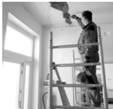
Zednické práce v budově mateřské školy.
