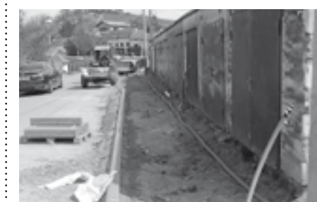
Výměna povrchu před garážemi na ulici Pod Břehe, směr k železničnímu přejezdu a Penzionu André.
