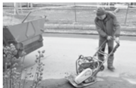
Oprava četných výtluků na vozovce v ulici Dlouhá.
