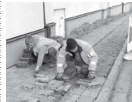
Rozebírání starého chodníku u II. stupně ZŠ před zahájením rekonstrukce vodovodního řadu.
