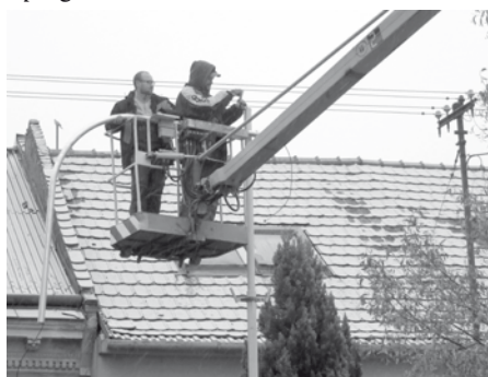
Instalace LED lamp nového veřejného osvětlení na ulici Hlavní.
