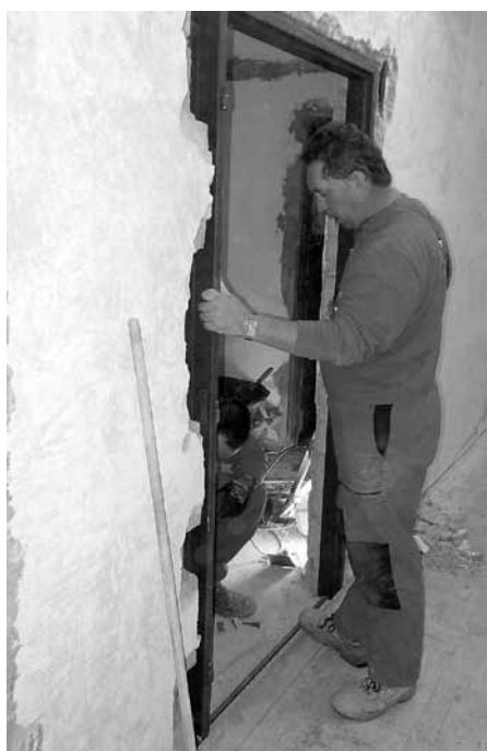
Oprava šaten a sociálního zařízení v tělocvičně základní školy.
