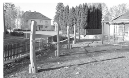
Instalace nového herního prvku na hřišti za kostelem.
