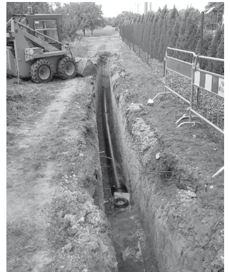
Pokládka potrubí nového přivaděče pitné vody do Velkých Pavlovic.
