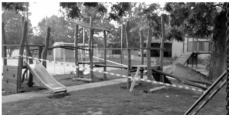
Instalace herního prvku „Nevěže tři“ na hřiště za kostelem.
