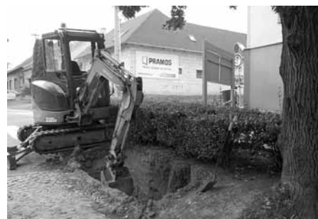
Zahájení opravy vodovodního řádu na ulici Hlavní.
