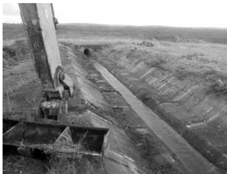
Vyčištěný odtokový žlab ČOV.
